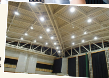
市内学校の耐震対策 電気設備外工事
