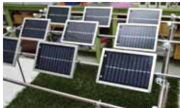
▲太陽光パネルを使ったソーラーシェアリングの模型。パネル部分は、太陽の軌道に合わせた、シーケンサによる可動式となっている。パネル部で発電させ、パネル下部の土地で耕作をする仕組み。千葉市内にある遊休地を利用した設置場所には、見学者が絶えない
