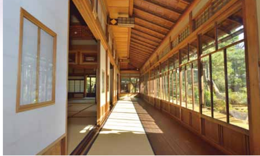
旧茂木佐平治邸の廊下の梁は長さ12mにも及ぶ。広間に入りきらない客のため、廊下の半分を畳にしたという点もユニーク
